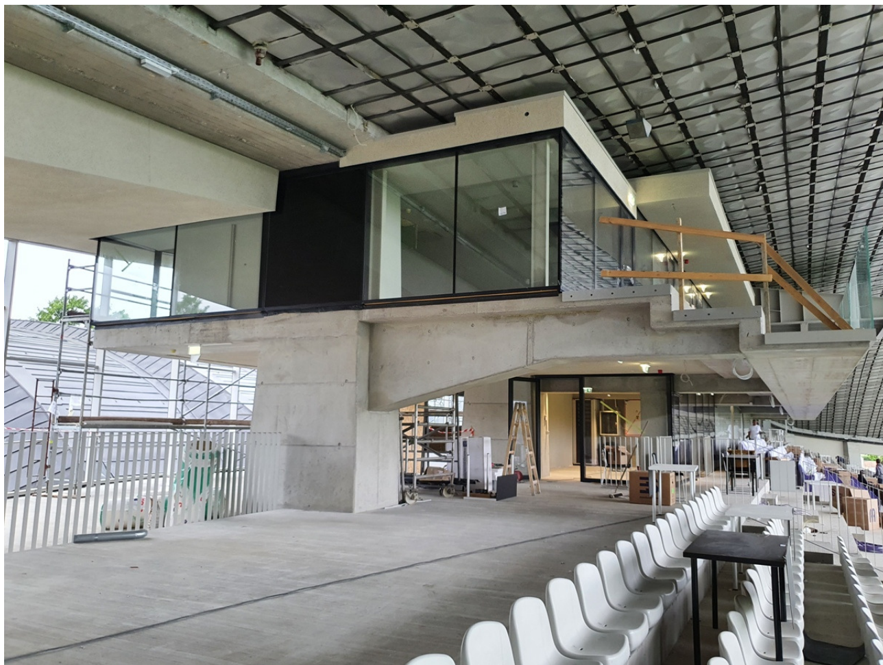
Slika 6: Konzolni nosilec VIP tribune
