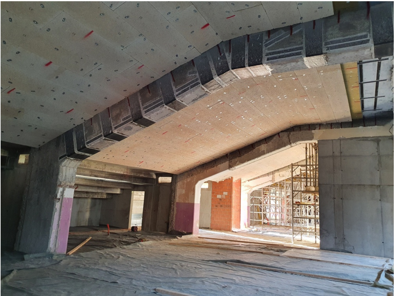
Slika 8: Ojačitev nosilcev tribun s karbonskimi lamelami
