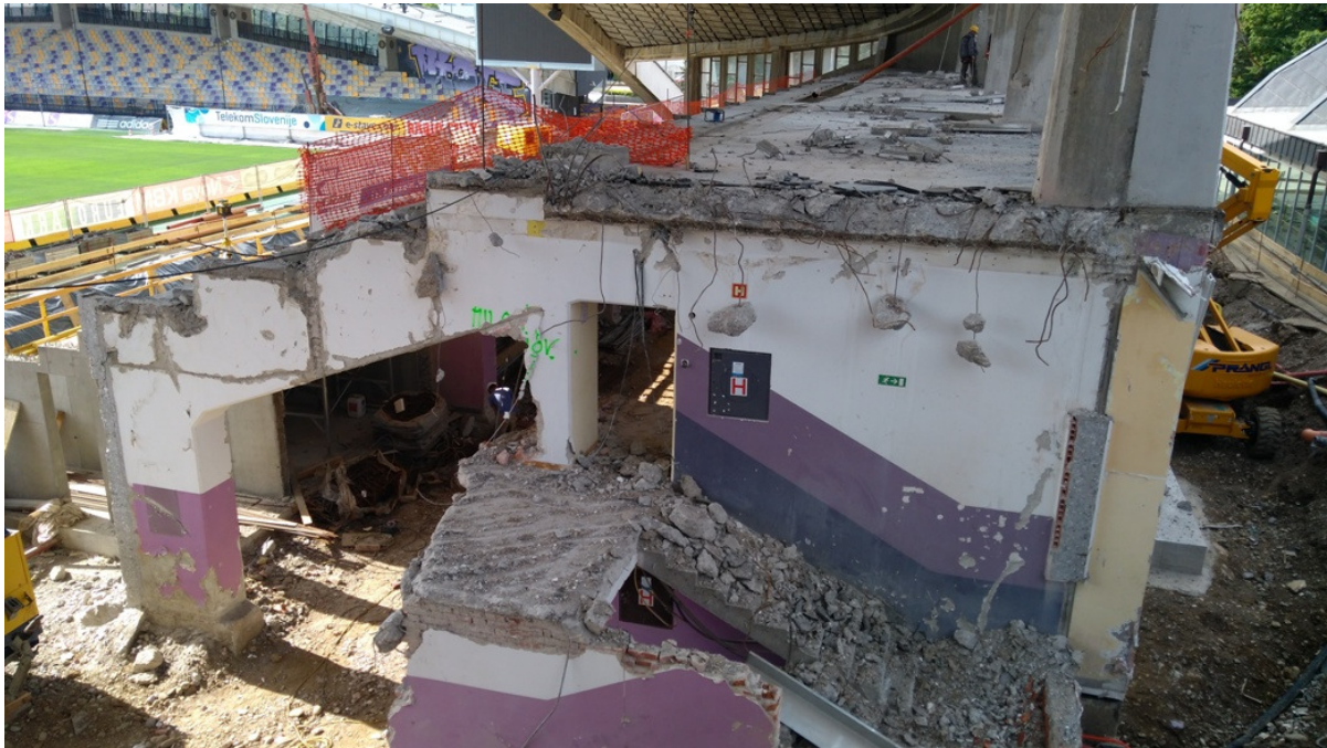
Slika 4: Demontaža centralnega dela tribune
