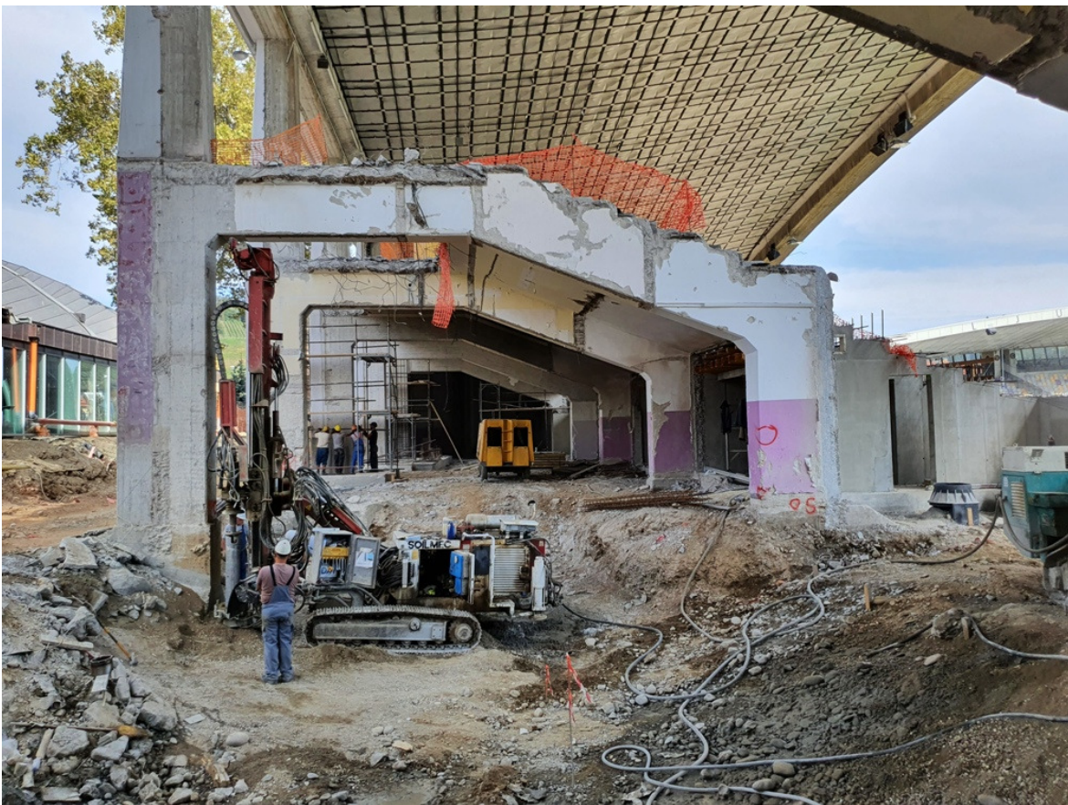
Slika 5: Izdelava mikropilotov ojačitve temeljev
