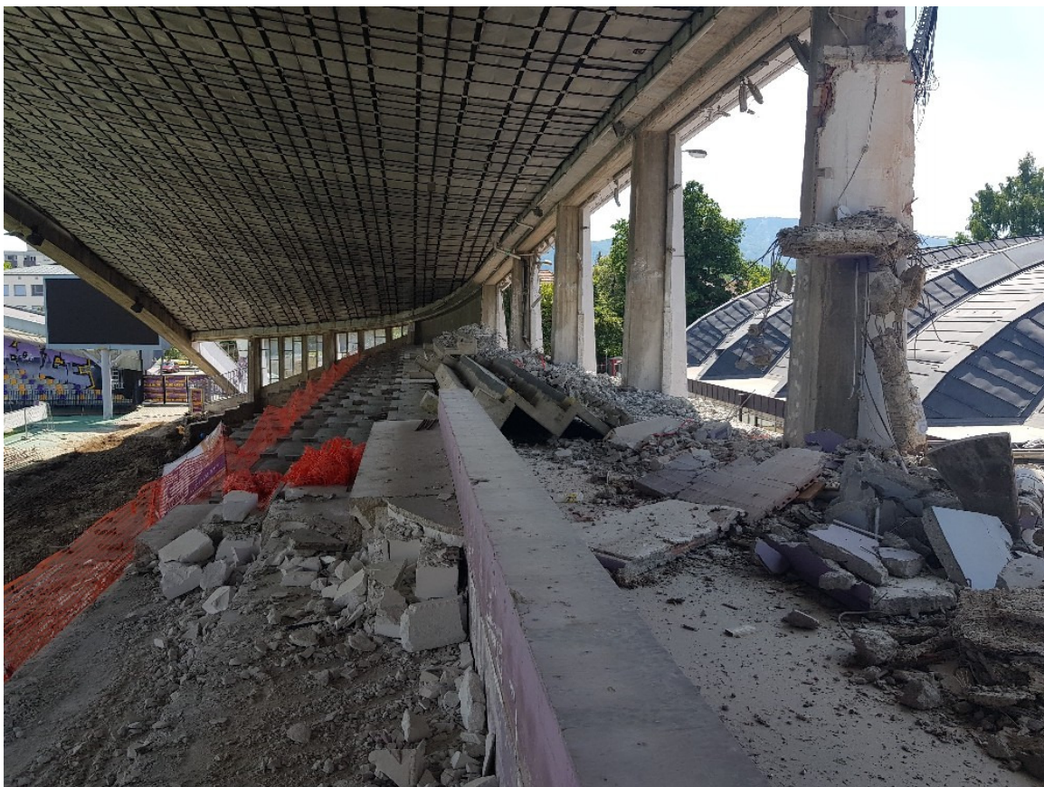
Slika 3: Demontaža tribune in zunanjih sten
