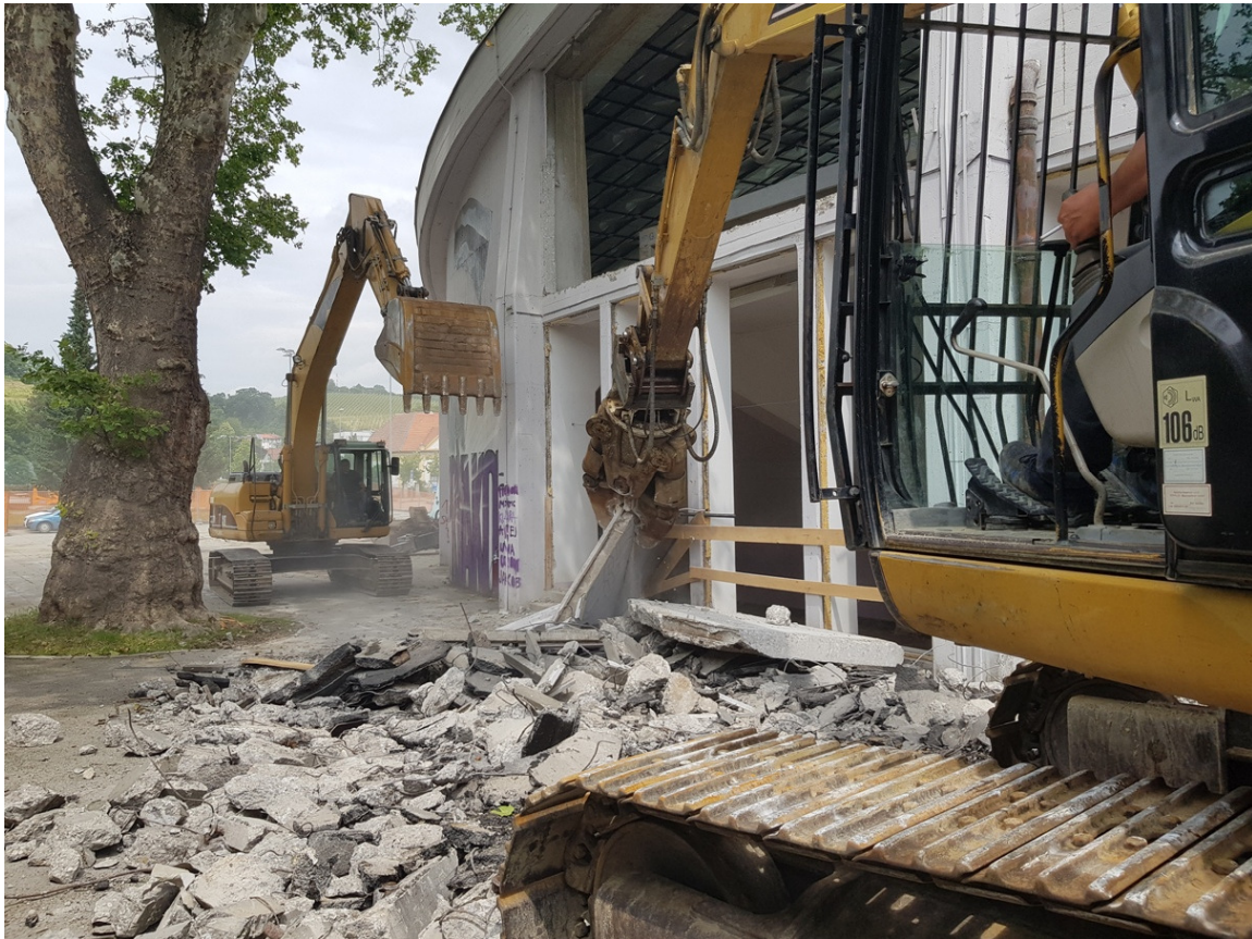
Slika 2: Demontaža klančine in zunanjih sten
