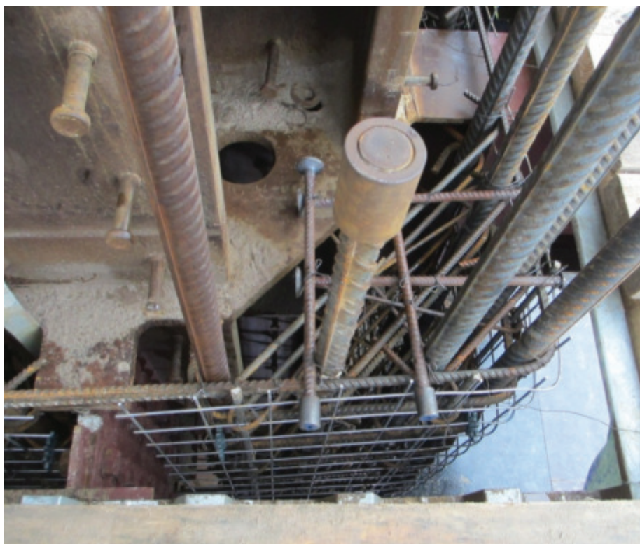
Slika 44 • Armatura stebra in sidra v vogalu stebra.
