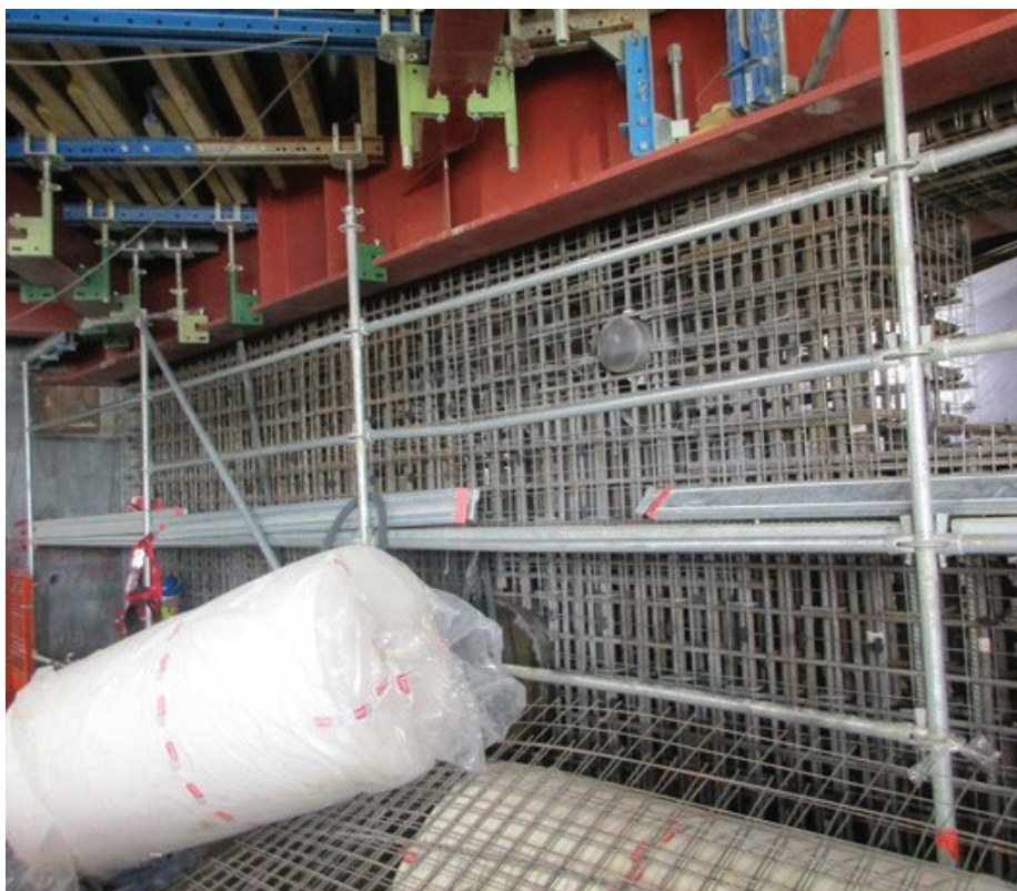
Slika 34 • Armatura stene prečnika v 33. etaži.
