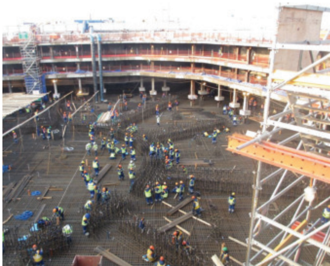
Slika 58 • Armiranje škatlastega temelja.
