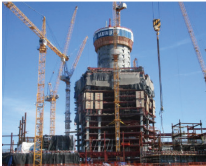
Slika 59 • Gradnja prvih etaž stolpnice.
