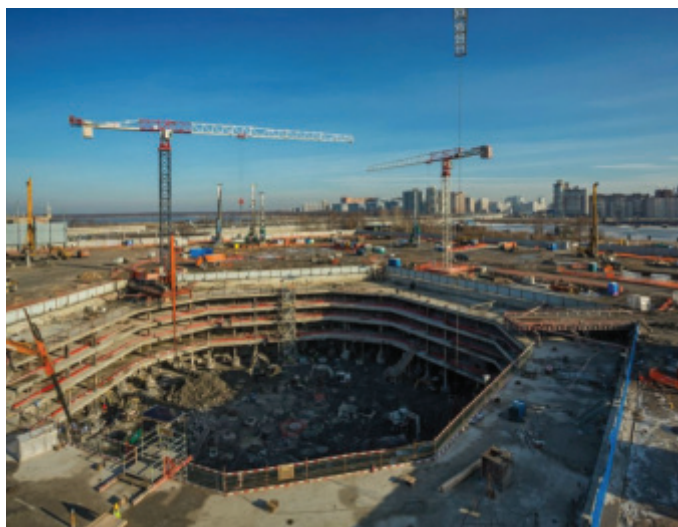
Slika 57 • Zaščita gradbene jame.
