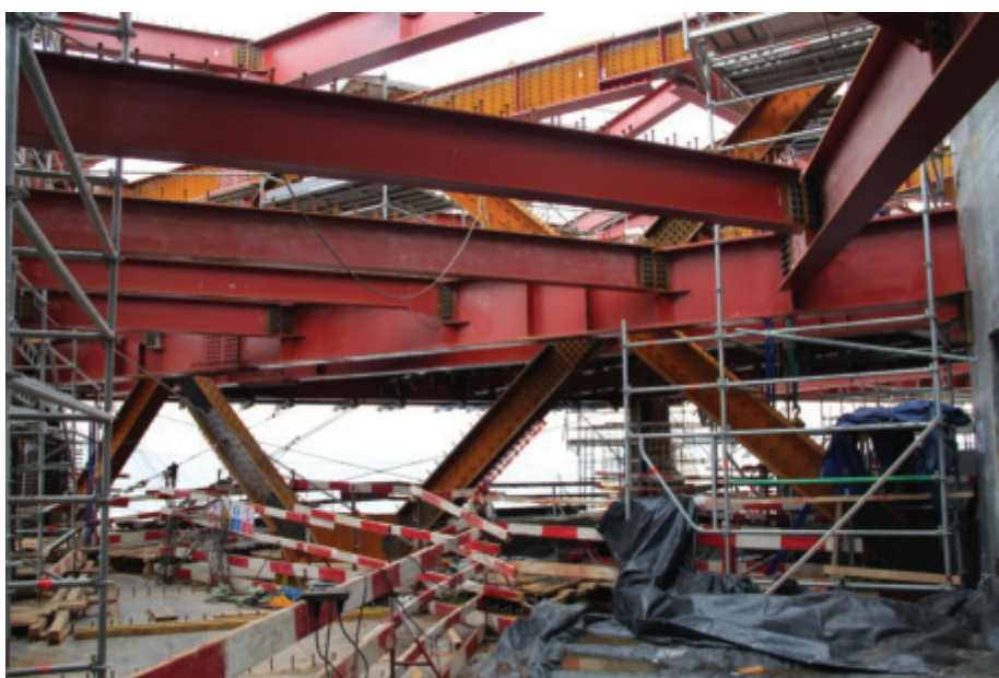
Slika 32 • Jekleno paličje prečnika v 33. in 34. etaži.
