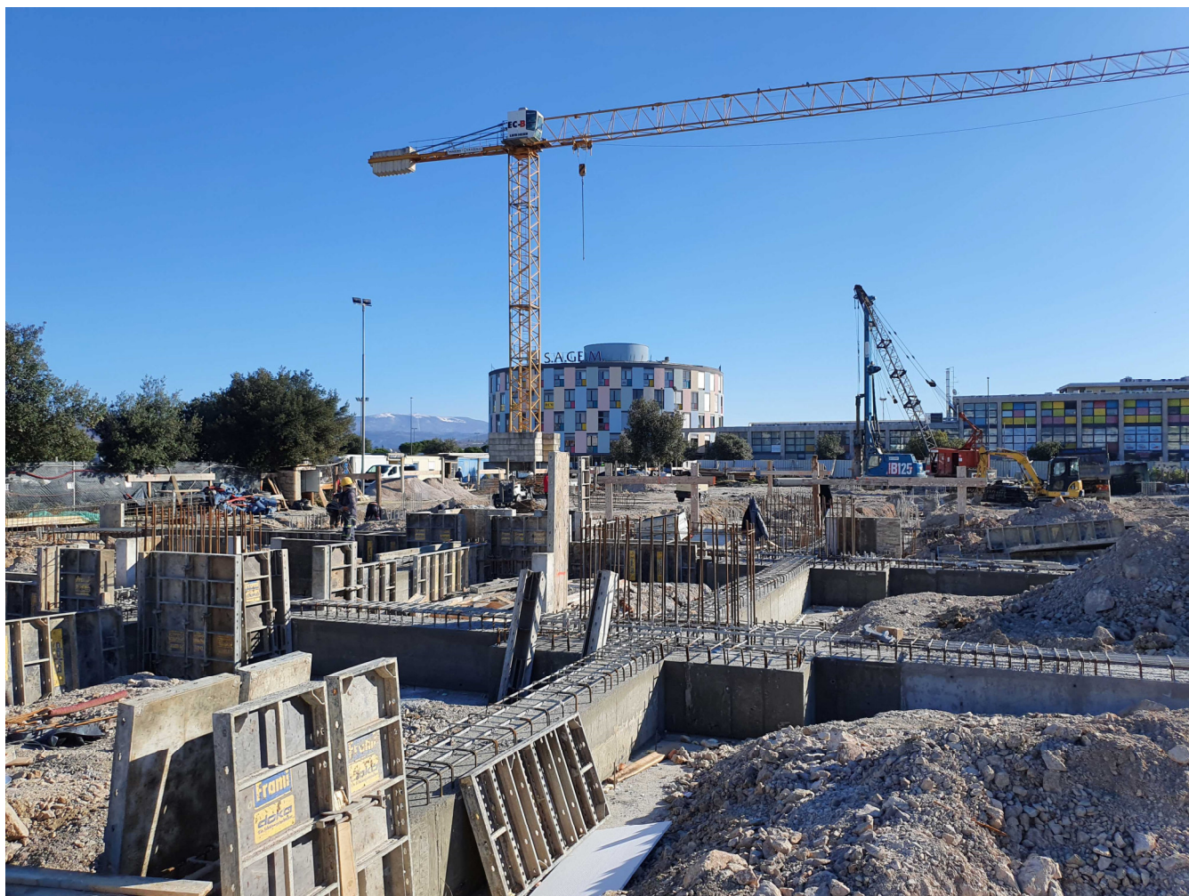
Slika 4: Izvedba pilotov, pilotnih glav in veznih gred
