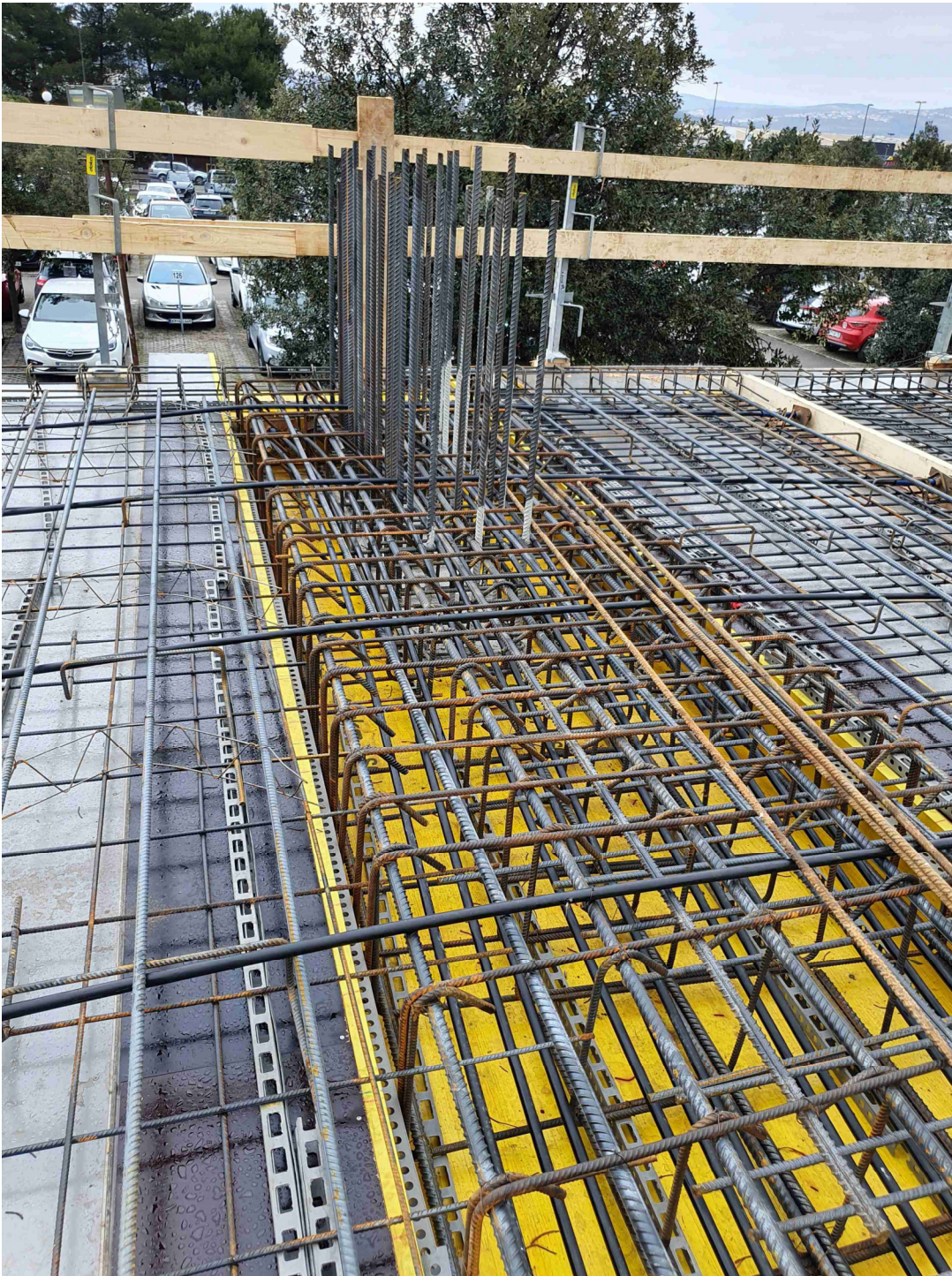
Slika 5: Prikaz prednapete in palične armature v nosilcu
