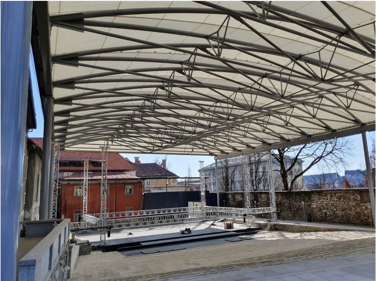
Slika 9: Pogled strehe po montaži
