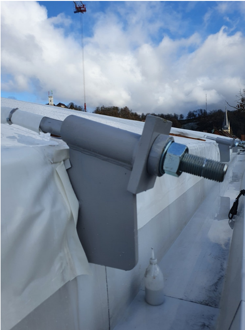
Slika 8: Sistem za prednapetje membrane
