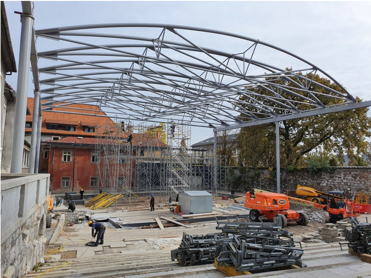
Slika 7: Montaža konstrukcij strehe
